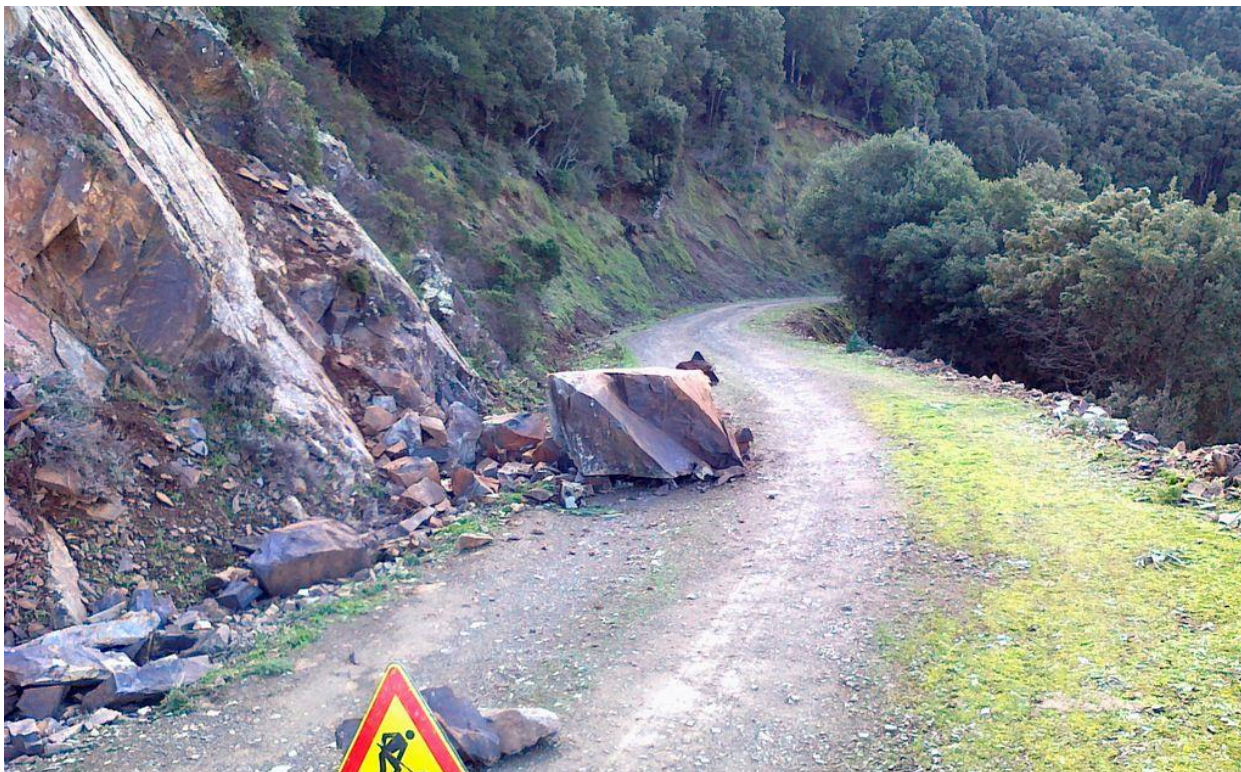
Figura 34. Frana per scivolamento in roccia, in Località su Fenu lungo la strada Vicinale Brabaisu, rilevata il 18/01/2013 (foto di archivio dell'UT di Burcei). La dimensione del blocco maggiore supera il metro cubo.
