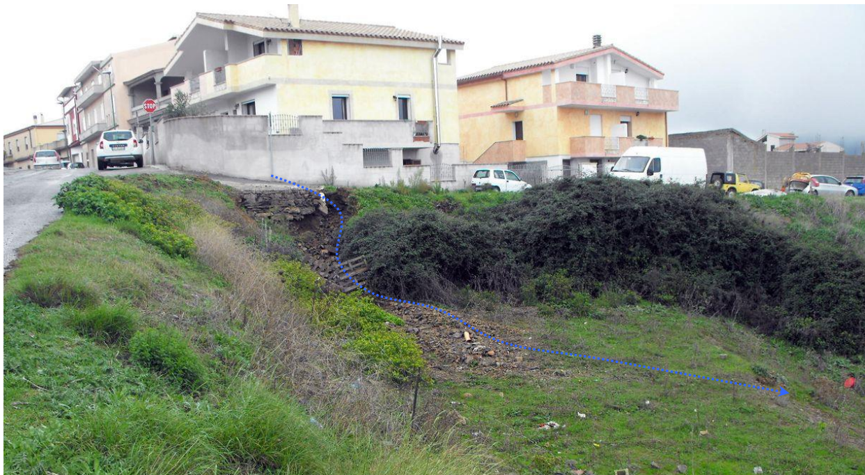
Figura 22. Intersezione tra la via Passus e la recente via De Gasperi, poco a monte dell'area precedente: profondo solco sul rilevato stradale derivante da deflusso concentrato raccolto entro l'impluvio.
