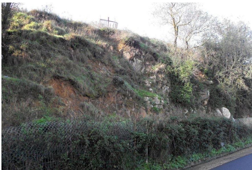
Figura 25. Taglio stradale sulla strada vicinale Ghirranu, nell'immediata periferia del paese: si nota l'alternanza tra roccia lapidea e coltre alteritica destrutturata, e fortemente dilavata.
