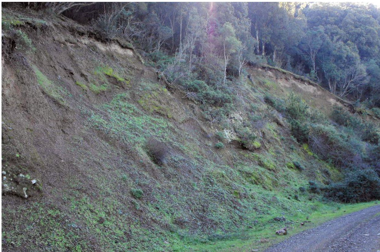
Figura 39. Strada Brabaisu: imponente nicchia di erosione per ruscellamento diffuso.
