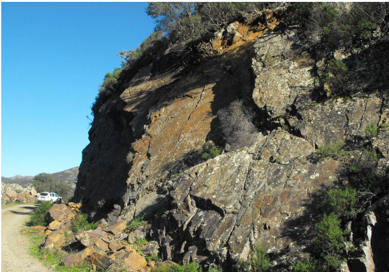
Figura 35. Stesso punto della foto 34: stato attuale.. Sono ben visibili gli ampi piani di scistosità, che pervadono l'ammasso in profondità, con giacitura a franapoggio rispetto al taglio stradale.
