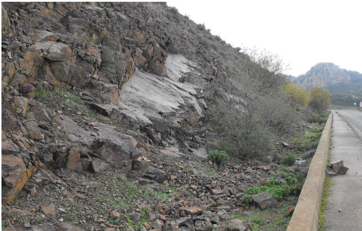
Figura 36. Scarpata stradale sulla nuova Strada Provinciale in località S'accua Mala: la giacitura a franapoggio dei piani di scistosità della Formazione di Pala Manna, qui assai fratturata ed allentata, danno luogo a modesti rilasci detritici composti di clasti e scaglie di pochi centimetri.
