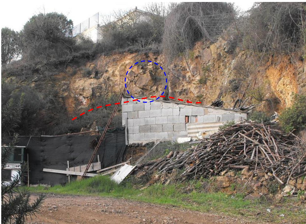
Figura 19. Fronte di scavo franato a seguito delle intense precipitazioni registrate nel novembre 2013. In evidenza nella circonferenza azzurra alcuni blocchi disarticolati e ancora in equilibrio precario. Alla base, il corpo di frana vegetato (tratteggio rosso).
